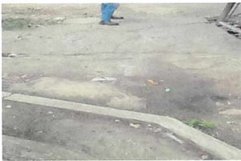
Foto 5: Cambio de torta de cemento y banqueta.
