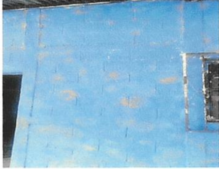
Foto1: Cambio de pintura de aulas, cocina puertas y balcones
