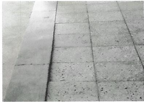
Foto 4: Cambio de piso de corredor
