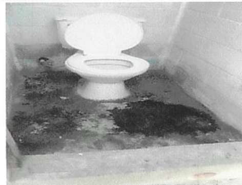
Foto 6: Mantenimiento de servicios sanitarios, limpieza y cambio de accesorios.
